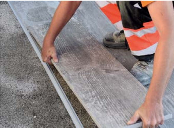
Kein Wippen dank durchgehender Auflage der Plattenkante.
